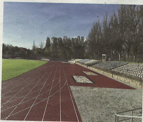
▼ V Nových Zámkoch teraz majú osemdráhový bežecký ovál. Dôvodom bolo len šesť dráh. Vpravo je tribúna, ktorú ešte čaká rekonštrukcia a prekrytie. ▼ foto: (Slovenský atletický zväz)
